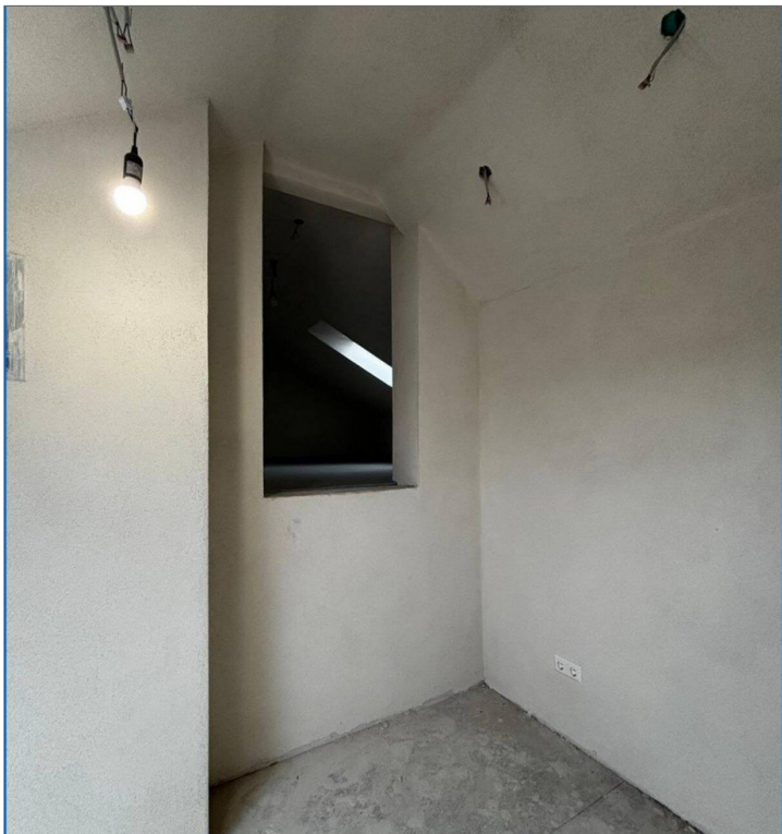
2. OG Zugang zum Speicher
