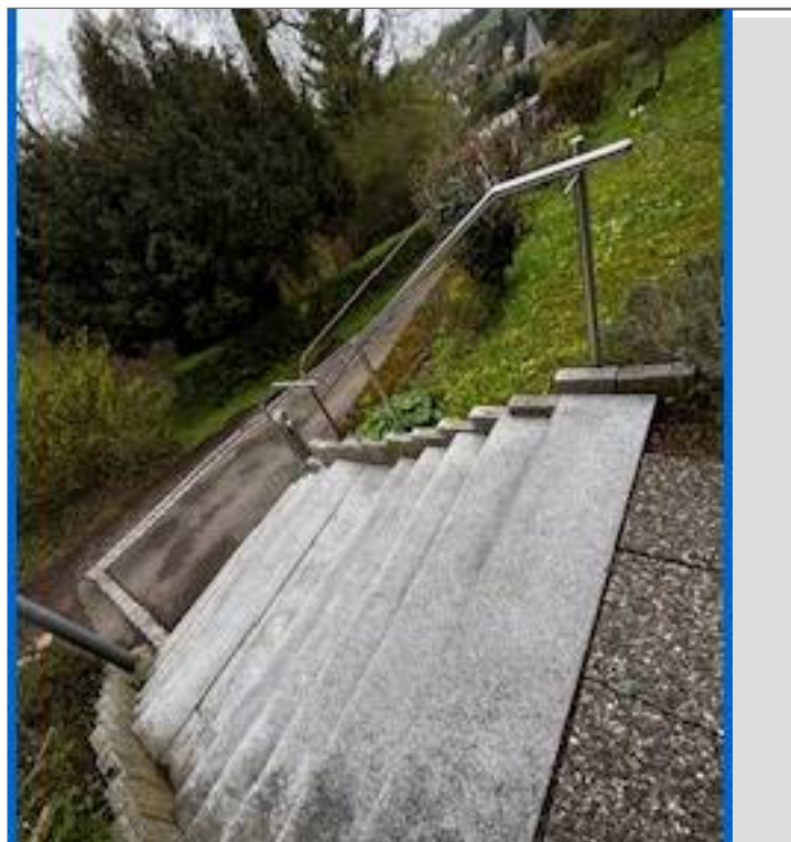
Treppe von Straße
