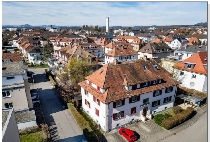
Haus Ansicht von oben
