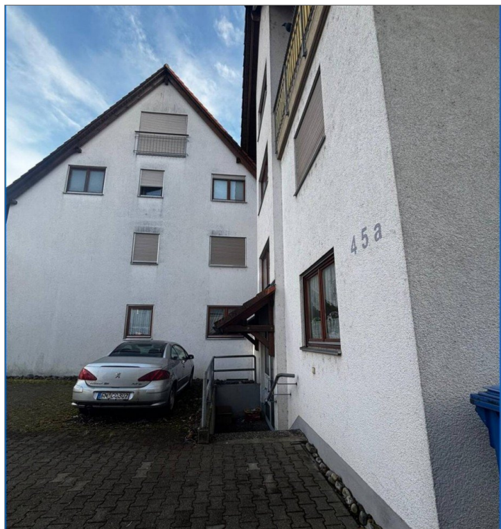
Haus Nr. 45 Eingang
