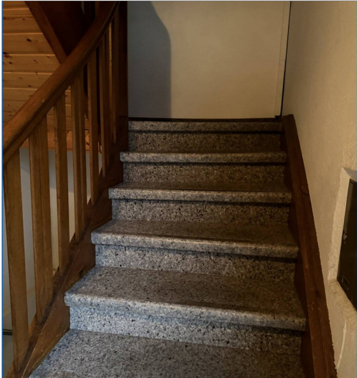
Treppe in Keller
