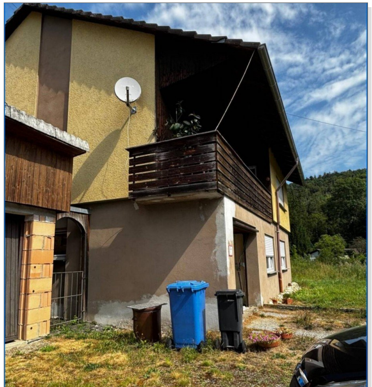
Ansicht Rückseite mit Garage)
