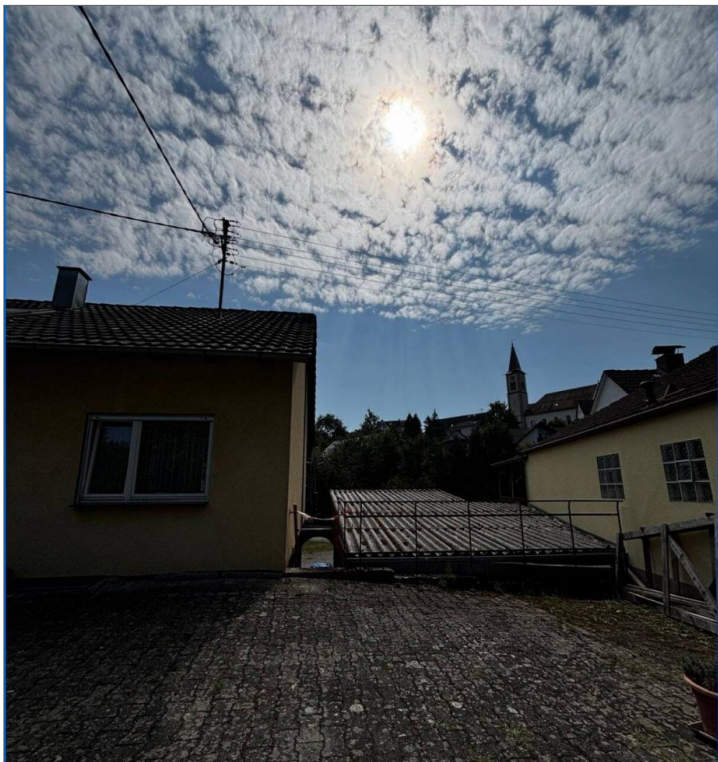
Ansicht rechte Seite mit Blick auf Garage
