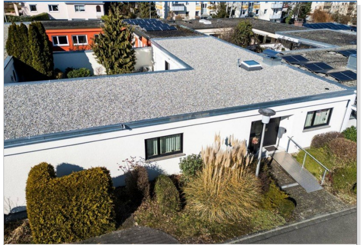
Blick auf neuem Dach
