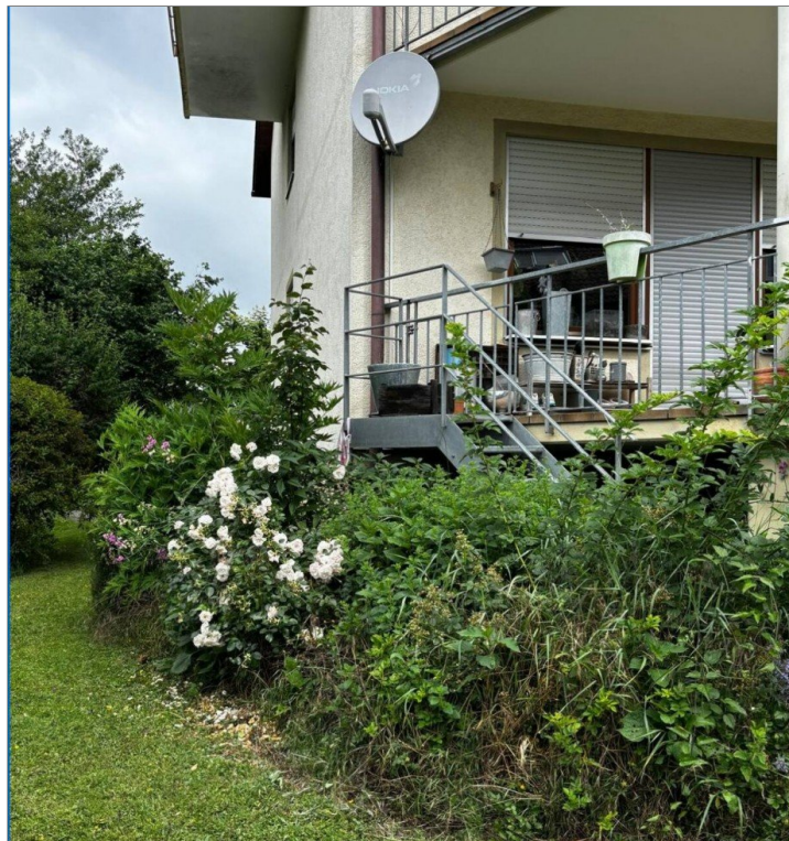
Zugang Balkon von Garten
