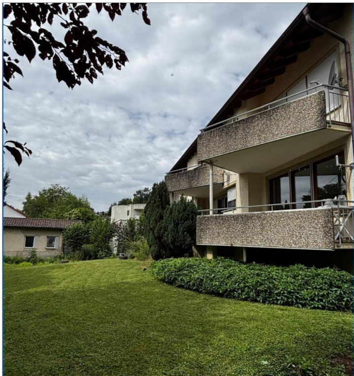
Ansicht Haus hinten mit Balkonen
