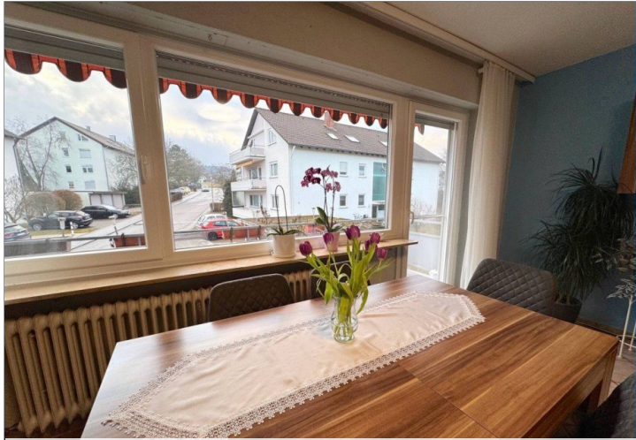
3 Fach verglaste Fenster
