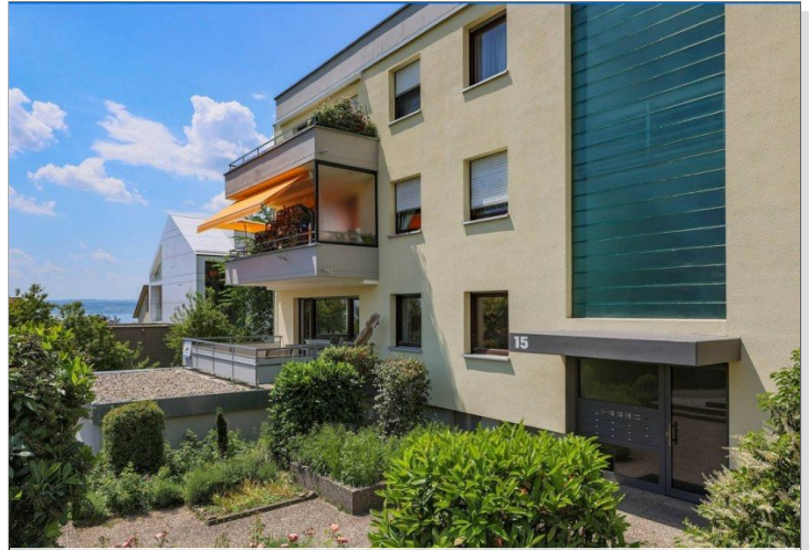
Hausansicht Blick zum Balkon und Eingang
