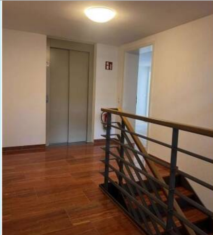
Saniertes Treppenhaus mit Personenaufzug
