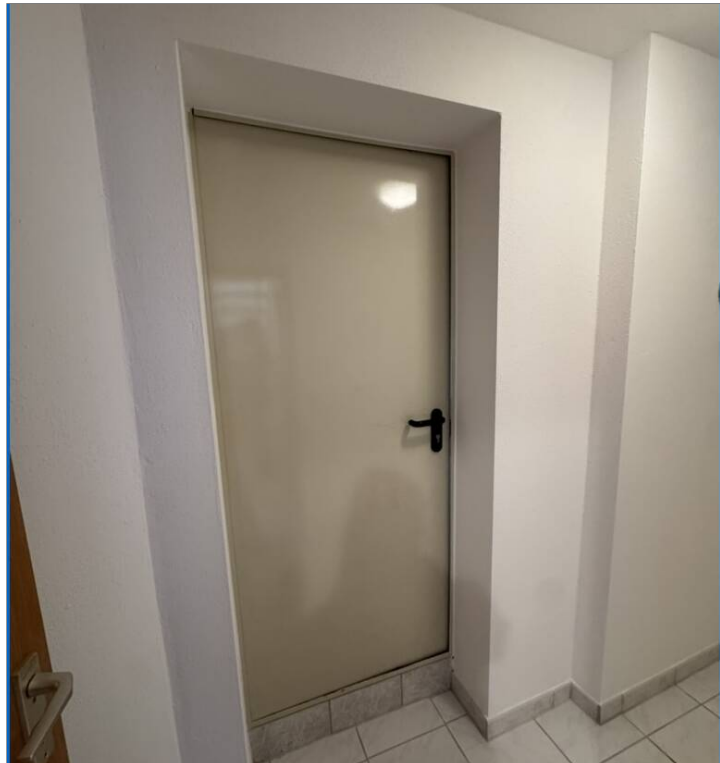
Zugang zum Treppenhaus MFH UG
