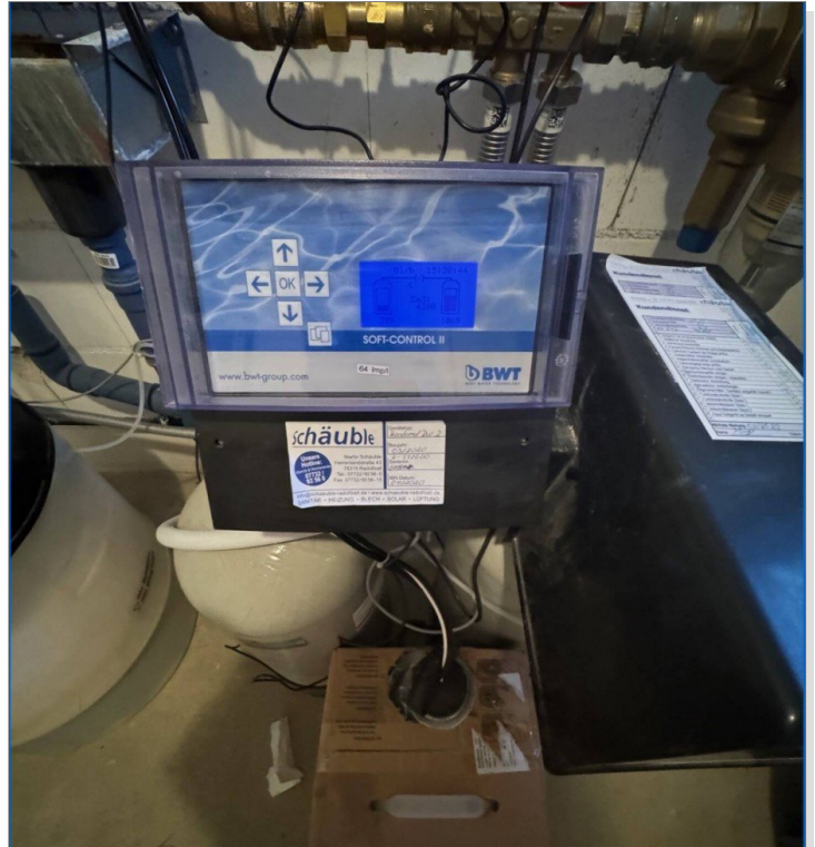
Wasserenthärtungsanlage
