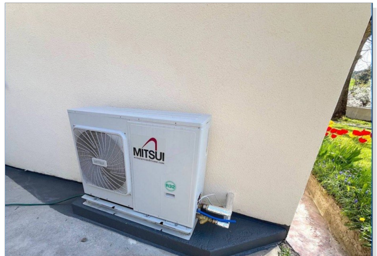
Luft-Wasser Wärmepumpe
