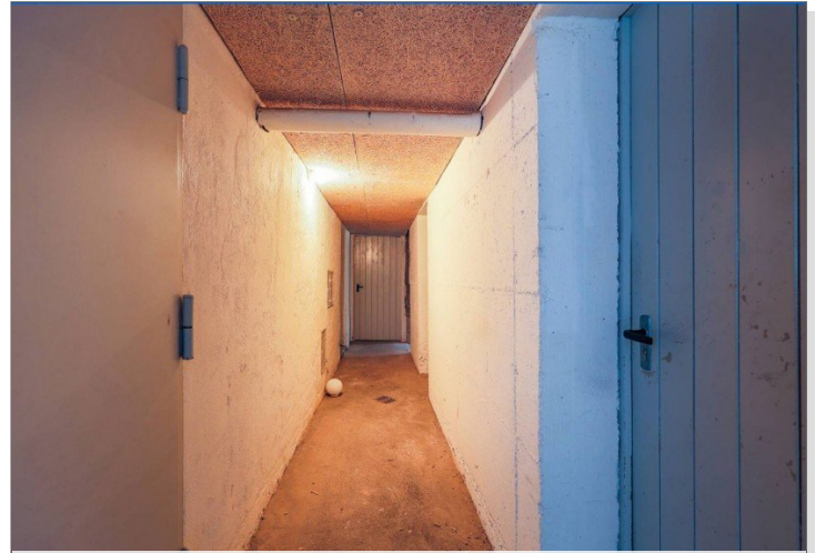
Keller Decke neu gedämmt
