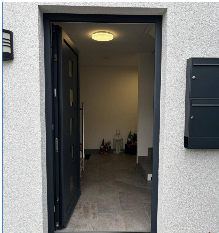
Hauseingang von Außen
